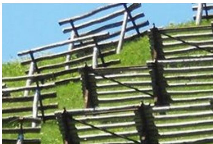
Figure 3 Ouvrage paravalanche en bois de châtaignier sur une pente raide. Ce bois provient d'une futaie. Photo: Orlando Jäger
