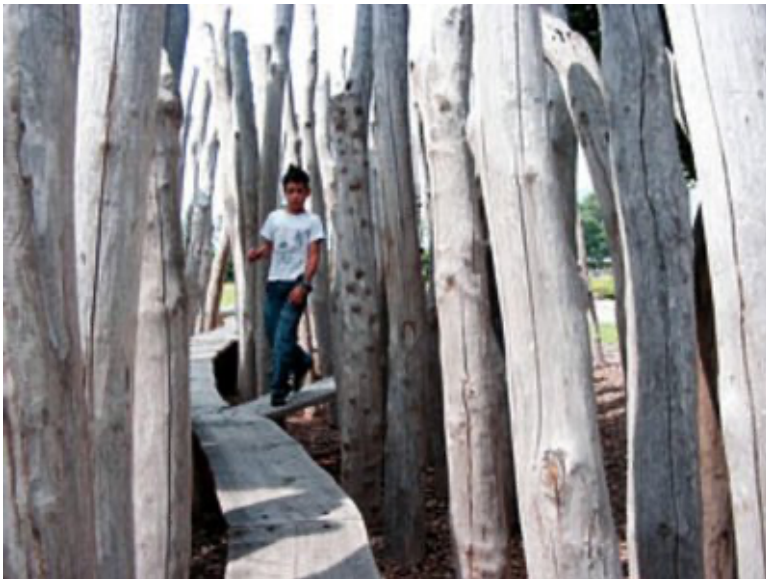
Figure 1 Des poteaux en châtaignier écorcé ou fraisé servent à fabriquer des jeux durables, ici un labyrinthe. Photo: Fulvio Giudici
