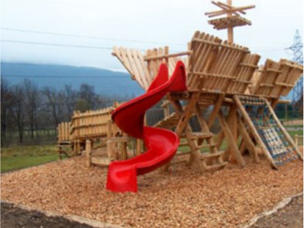
Figure 2 Constitué de copeaux de châtaignier, le revêtement de 40 cm d'épaisseur sous "l'Arche de Noé" à Gudo respecte toutes les normes de sécurité. Photo: Fulvio Giudici
